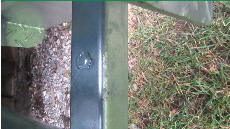
Auftritt wird mit Konsole und Winkel verschraubt, Schrauben 8 x 30
