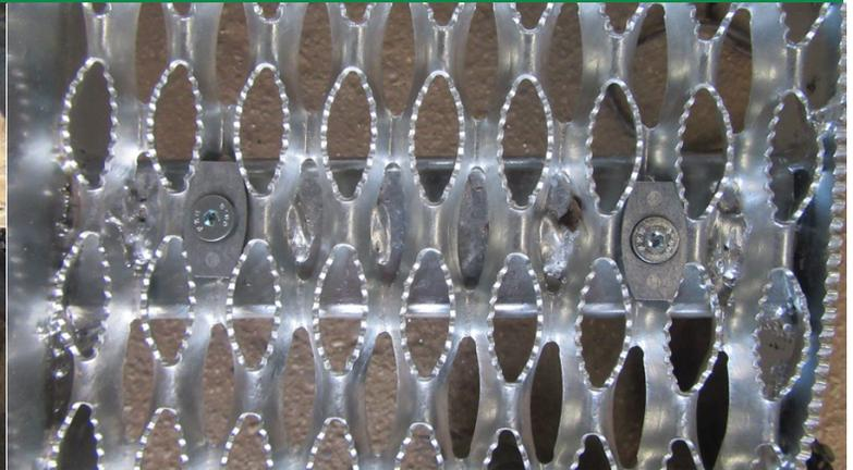
Auftritt wird mit 2 Senkkopfschrauben 8 x 70 u. 2 x Rondelle mit Tritthalter verschraubt
