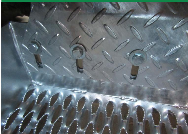
Schutzblech wird mit 3 Schrauben 10x25 mit Beilagscheiben 10,5x30 mit Auftritt verschraubt
